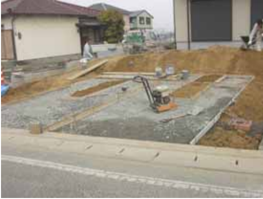
駐車場工事 砕石転圧
