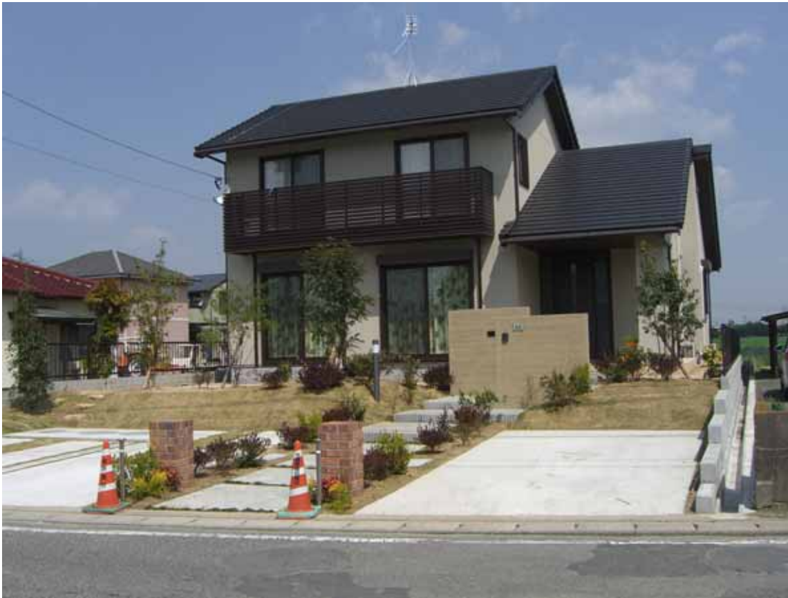
施工途中調査終了
