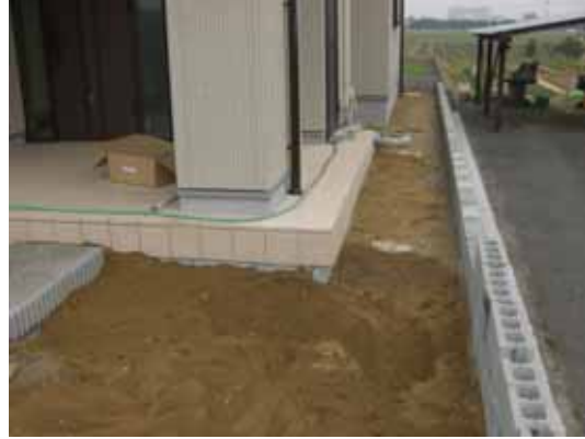
建物周辺整地状況確認
