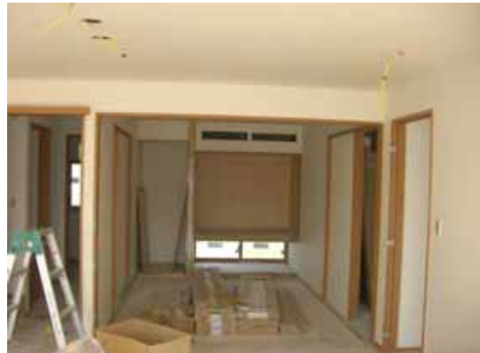
内装仕上げ工事
