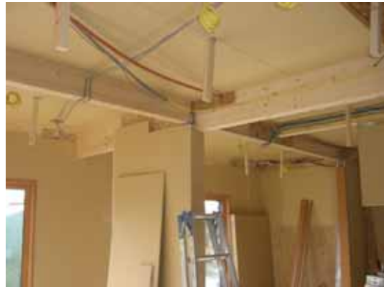
壁、天井のボード張り状況確認
