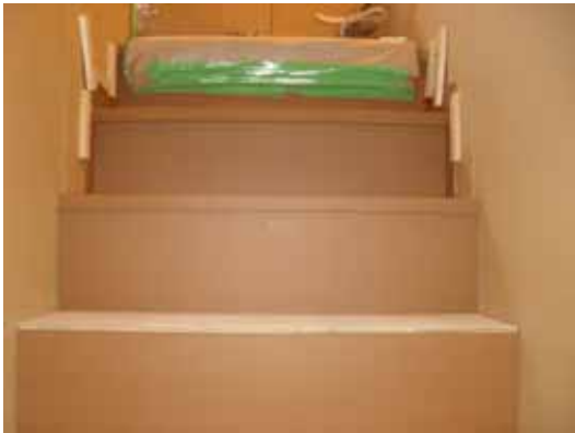
階段組立状況
