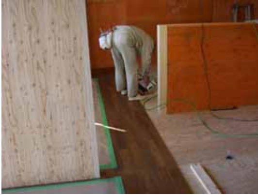
床フローリング張り状況確認
