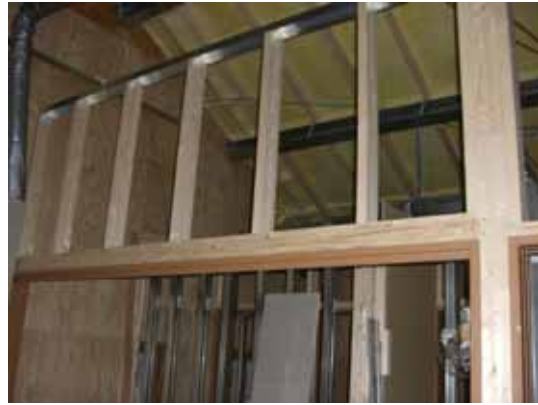
壁の間仕切状況確認
