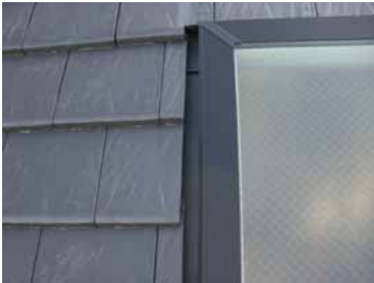
屋根天窗取合い確認
