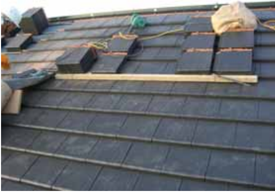
屋根の瓦葺き状況
