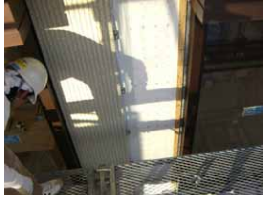
外壁 壁サイディング貼状況
