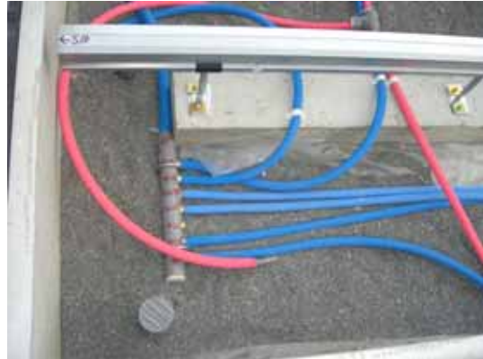
給水給湯配管状況
