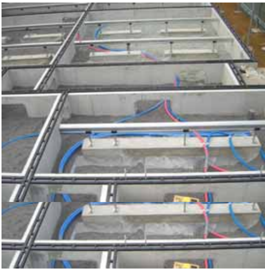
給水給湯配管状況
