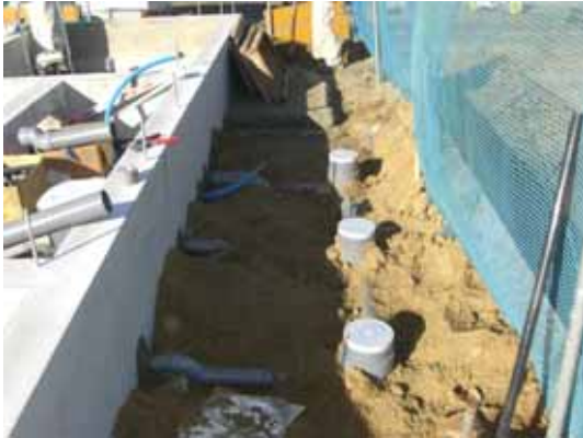
屋外排水敷設状況確認
