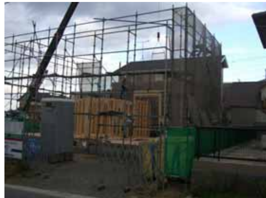
パネル工法による組立状況
