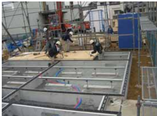
基礎パッキンの取付確認
