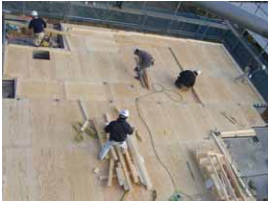
床版取付状況
