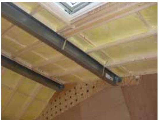
接合金物の取付状況確認
