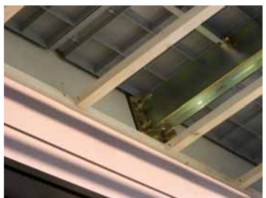
接合金物の取付状況確認
