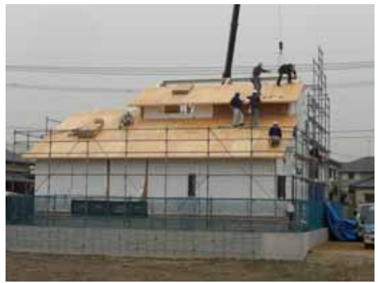
屋根の組立状況
