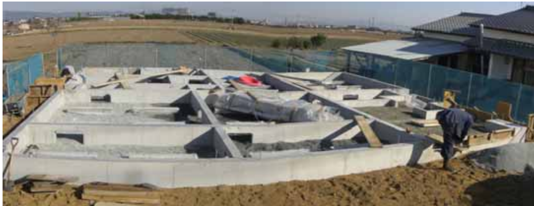
基礎の出来型確認 (布基礎)
