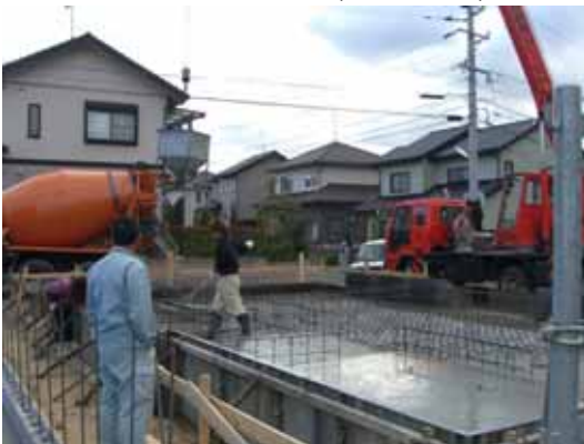
基礎ベース(べた基礎)のコンクリート打設 コンクリートの材料確認
