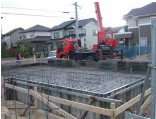
基礎ベースの配筋確認(べた基礎)
