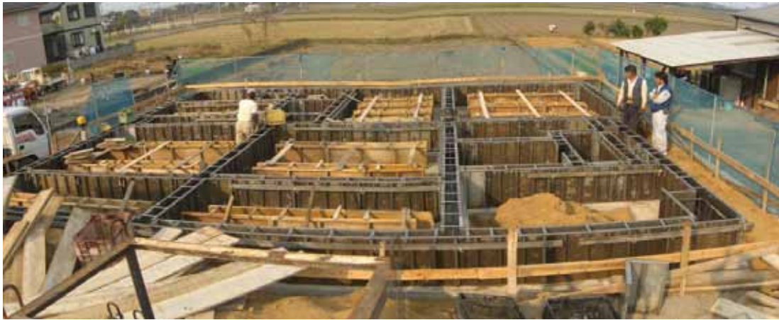
立上りの型枠組立(寸法チェック)
