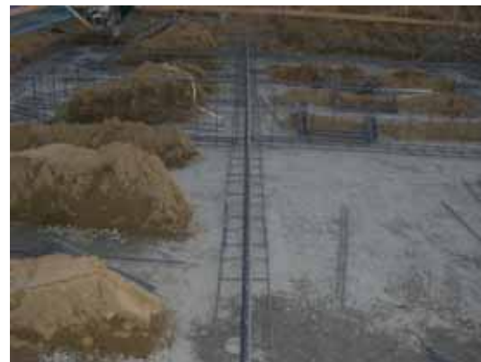
基礎ベースの配筋確認(布基礎)
