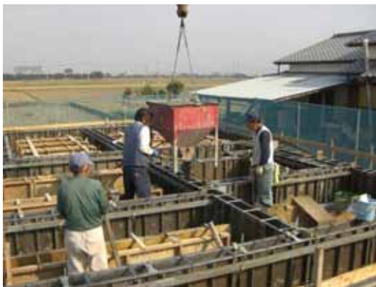
立上り コンクリート打設
