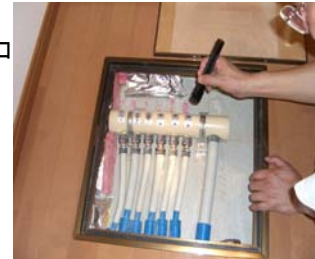
配管の施工状況
