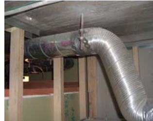
換気ダクトの 配管状況
