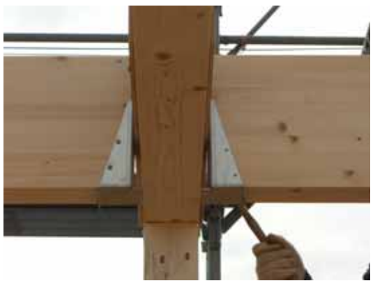
接合金物の取付状況確認
