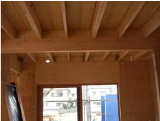
2階床の組立状況
