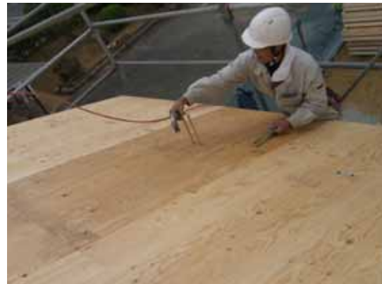
屋根パネルの組立状況
