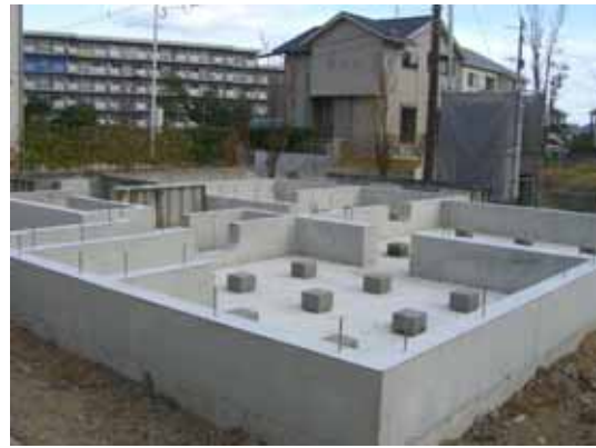
基礎の出来型確認 (べた基礎)
